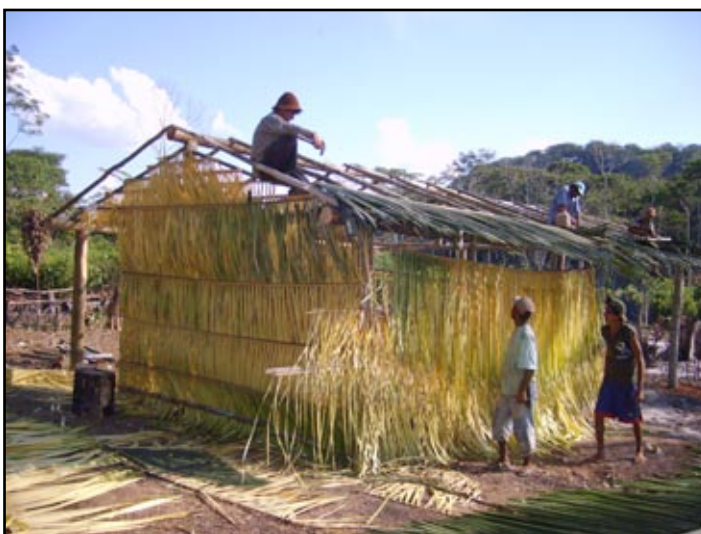
Mutirão para construção do barracão da Assembléia
